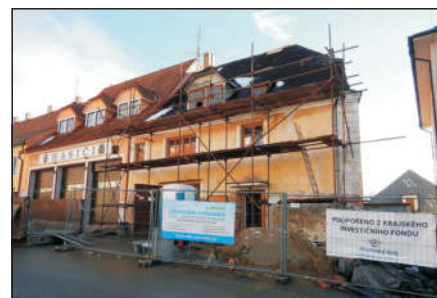
Oprava domu čp.188
