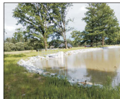
Oprava rybníka v Byňově
