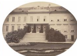
Vstupní partie / Entrance area, Franz Píka, ca. 1860. Ústav dějin umění AV ČR
