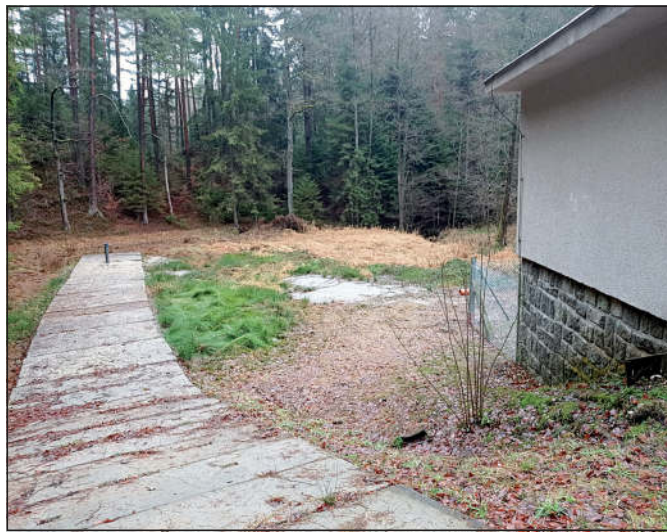
Vrt HV3 u úpravy vody Veverč
