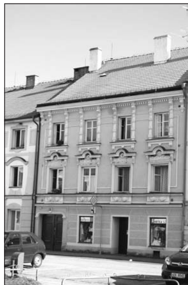
Rekonstrukce střechy domu čp. 11 na náměstí
