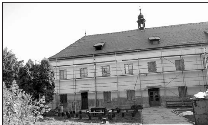
Rekonstrukce školní družiny
