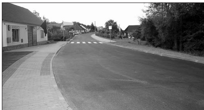
Průtah Údolím a kanalizace
