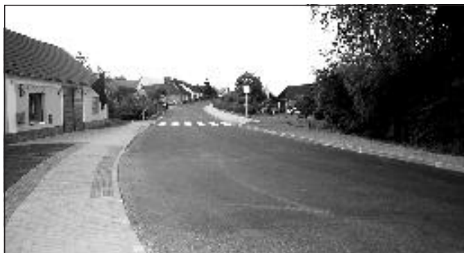
Průtah Údolím a kanalizace
