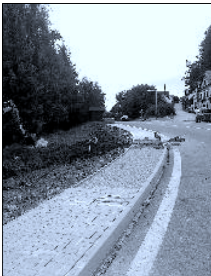
Údolí – rekonstrukce chodníků
