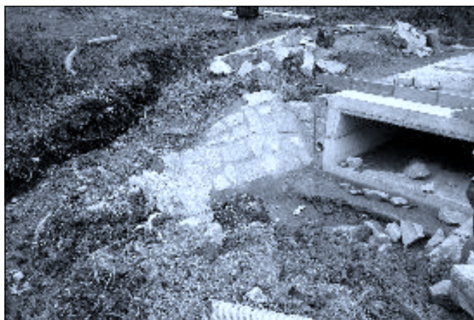
Rekonstrukce propustku pod místní komunikací ve Vyšném
