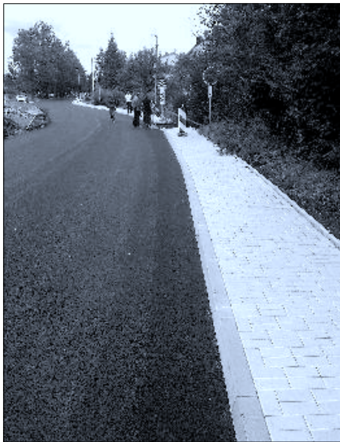
Chodník v Jakuli nyní čeká na doplnění lávky, díky vstřícnosti Správy a údržby silnic navíc došlo k položení nového asfaltového koberce, kterým jsme společně vyřešili i otázku odvodnění
