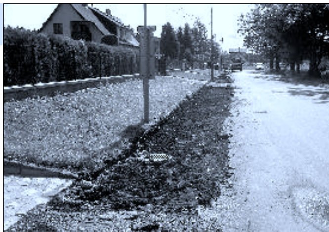
Rekonstrukce chodníku na Jakuli
