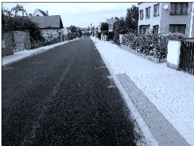
Rekonstrukce ulice Vilová
