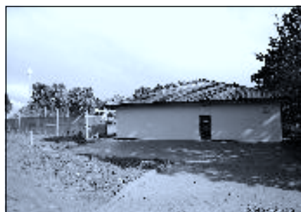
Pasivní dům u fotbalového hřiště
