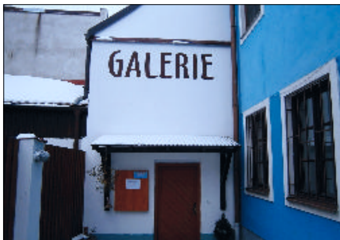
Stavební úpravy vstupu do Koželužny
