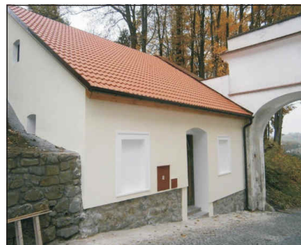
Rekonstrukce městské vstupní brány
