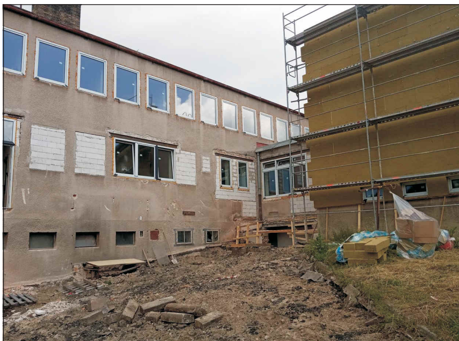
Stavební úpravy dvora
