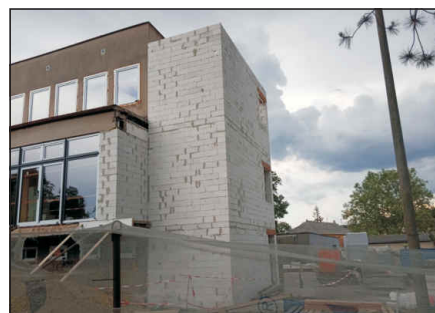
Přístavba únikového schodiště
