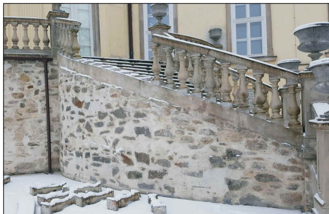
Zabradlí balustrády novohradského zámku
