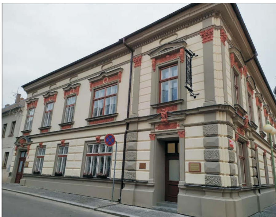
Oprava fasády s plastickými prvky včetně říms, obnova barevného nátěru Česká č.p. 74
