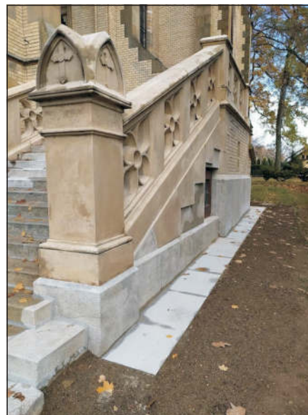
Oprava vstupního schodiště Buquoyské hrobky – vnitřní úpravy, opatření ke snížení vlhkosti zdiva ↑↓
