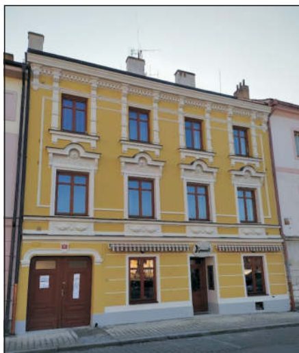
Oprava fasády s plastickými prvky včetně říms, obnova barevného nátěru nám. Republiky č.p. 11
