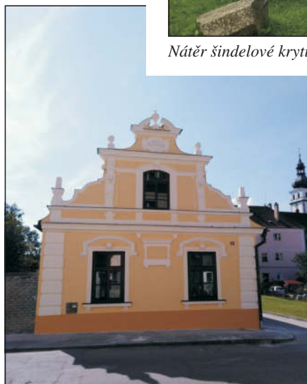
Oprava fasády štítu domu, Husova č.p. 78
